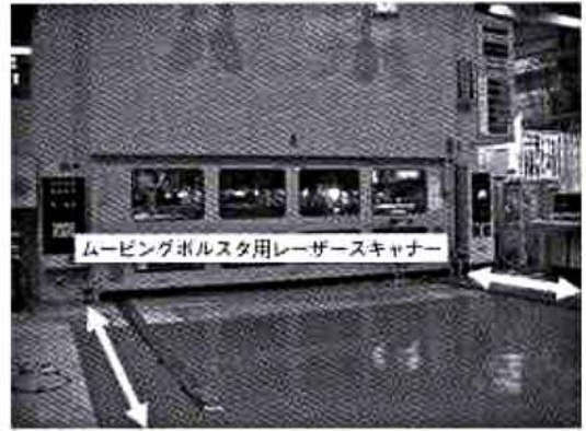
写真1 ムービングボルスタに使用したレーザー式安全装置
